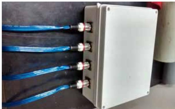
**Figura 2.** Caja de resguardo, protección y seguridad a la intemperie para el equipo de medición.
